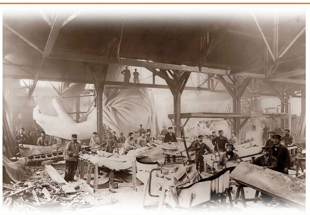
Cantiere di costruzione della Statua della libertà, Parigi, 1884
